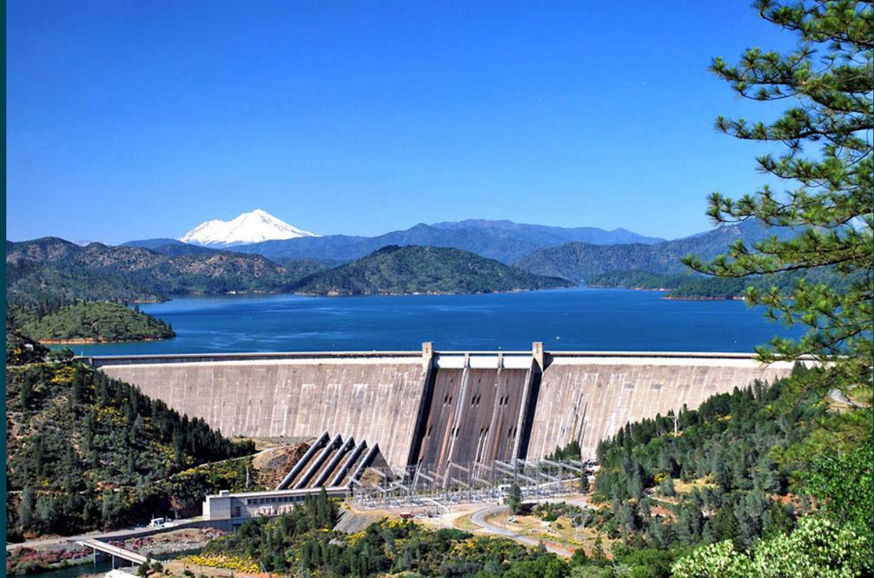
Shasta Dam. USBR NCAO. 2022.
